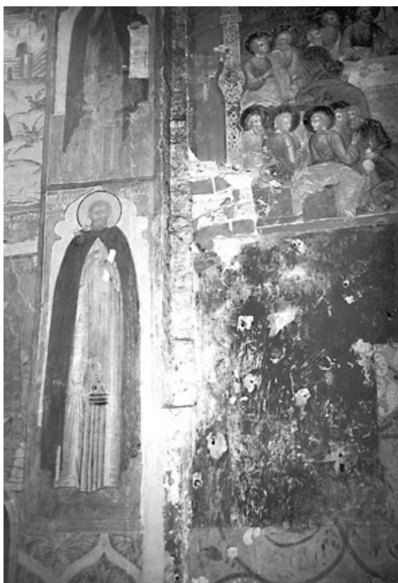
Ил. 5. Фрагмент паза для иконостаса в южной стене Преображенского собора суздальского Спасо-Евфимиева монастыря.
